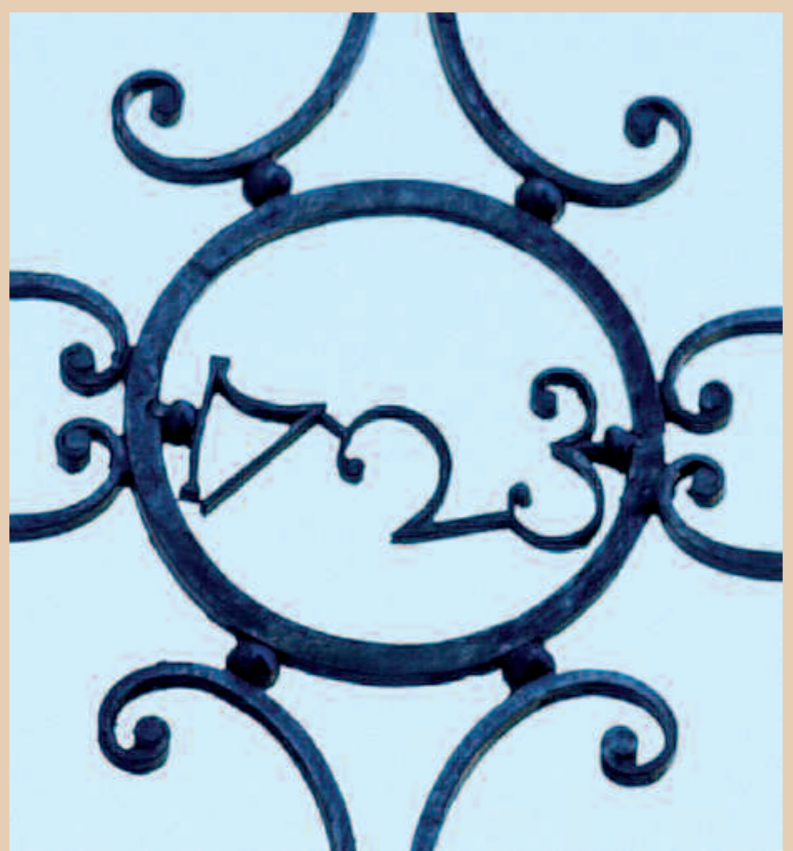
Garde-corps du balcon.
