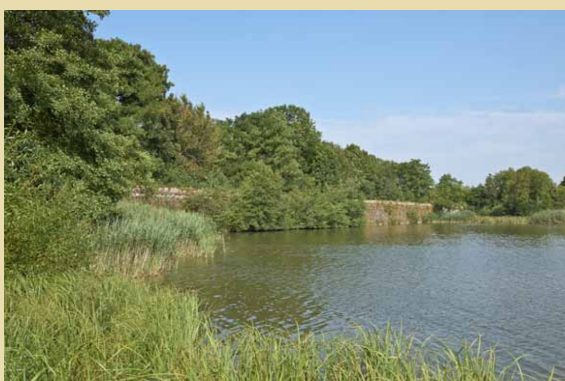
Digue maçonnée sur l'étang de Réchicourt.
