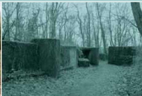
Fort d'Illange Parapet d'infanterie en béton
