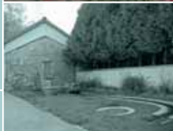
Rue du Château d'eau, fontaine installée en 2006, à l'emplacement du lavoir de 1851 dont un mur en moellon calcaire subsiste
