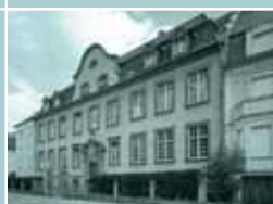
THIONVILLE , ancienne école impériale des mines de style baroque allemand, construite en 1907 sur les plans de l'ingénieur Wempe où étaient formés les agents de maîtrise de la sidérurgie et des houillères. L'entrée est monumentalisée par le portail en grès rose.
