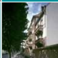
THIONVILLE , ensemble de logements (avenue Merlin) réalisés par Josef Stübben en 1905 pour les fonctionnaires des chemins de fer. Comme tout projet public, il est étudié à Strasbourg puis à Berlin en 1904. Les façades offrent un jeu de polychromie (enduit blanc, brique et grès rose), qui correspond à des modèles diffusés dans de nombreuses villes, comme à Metz Plantières.
