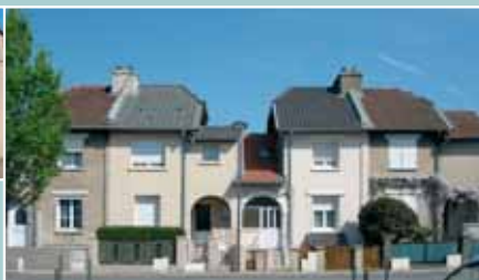
TERVILLE, PARC MON LOGIS. Cité construite en 1905. Deux modèles de maisons jumelles avec jardin, décor d'arcade en brique au-dessus des entrées et mur de refend pare-feu en saillie sur la façade et le toit. Réaménagée en 1981
