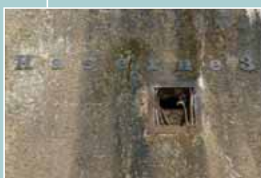
Caserne 3, détail de la façade
