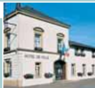
La Mairie. Bâtiment néo-classique construit dans la seconde moitié du XIX e siècle. L'entrée principale, située Grand Rue est déplacée lors d'un agrandissement en 1925.
