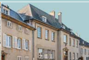
Grand'Rue, groupe scolaire Moselly. Bâtiment du XIX e siècle, milieu de la mairie, ancienne école des garçons ; le groupe Moselly II est construit dans les années 1980 à l'arrière, dans la cour.
