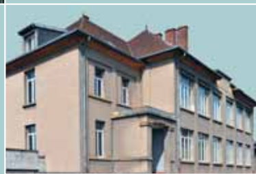
École du Moulin, construite dans les années 1930, à proximité de la cité
