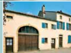
KOEKING Ferme à trois travées (XIX e siècle) et usoir (espace entre la ferme et la route où étaient entreposés le bois de chauffage et le tas de fumier)
