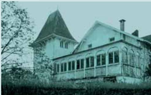
Savonnerie, ancien logement patronal
