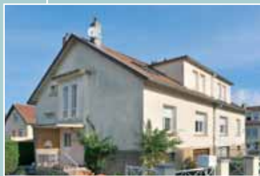
MANOM, lotissement construit derrière le cimetière en 1954
