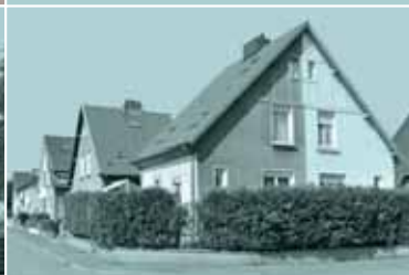
Modèle n°4 : maisons jumelles avec pignon sur rue à décor de faux pans de bois en ciment moulé (parfois disparus)
