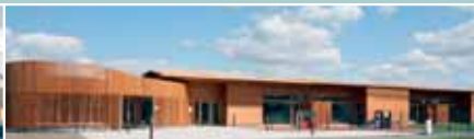
Les Petits de l'Olympe. Cet équipement communautaire d'accueil des jeunes enfants a ouvert ses portes le 1 er septembre 2010. Bâtiment éco-responsable à ossature bois. Construit aux normes BBC, il a été labellisé par l'ADEME.
