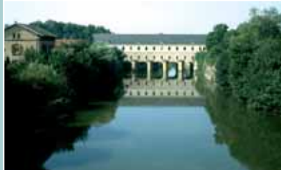
L'un des deux ponts-écluse à six arches en anse de panier conçu par Cormontaigne, quasiment achevé à sa mort en 1752
