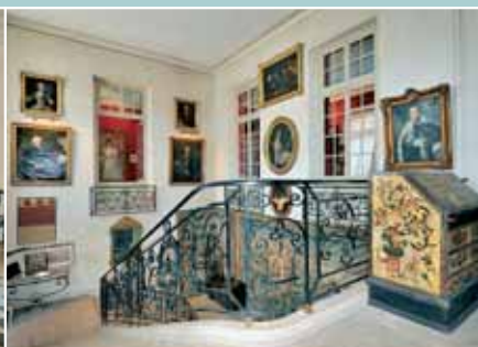
Grand escalier tournant à trois volées droites, séparées par des repos, vu depuis le premier étage. La rampe en fer forgé provient de la démolition, entre les deux guerres, de l'Hôtel de Bertier de Sauvigny (rue Beranger, dans le Marais à Paris) comme les garde-corps des bates.
