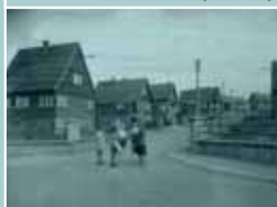
YUTZ, CITÉ SAINTE-BARBE. Anciens chalets de Haute-Yutz vers 1950 ; détruits et remplacés par des lotissements
