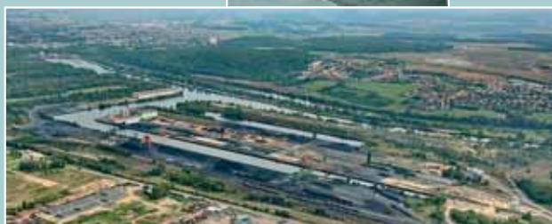
Le port de Thionville-Illange-Uckange. Au fond, la commune d'Illange
