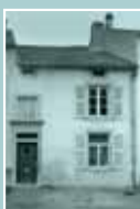
ILLANGE, ROUTE DE THIONVILLE Maison de manouvrier avec linteau décoré et daté 1859
