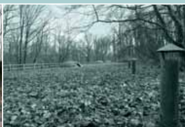
Batterie cuirassée : vue de trois tourelles tournantes et cheminées de ventilation des casemates
