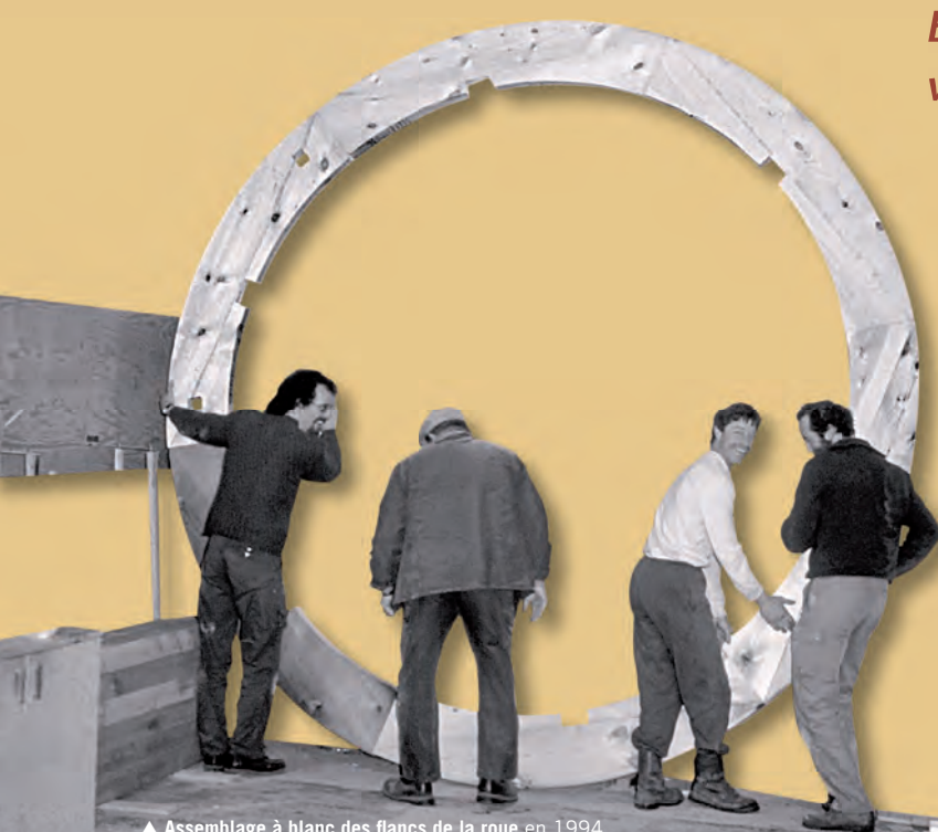
▲ Assemblage à blanc des flancs de la roue en 1994
