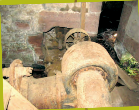
▲ Turbine de type Francis dite « escargot » à la scierie Hardy aux Rouges-Eaux (88)
