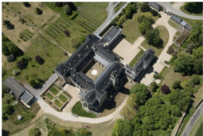
Abbaye d'Épisy, vue aérienne du site (2011).
