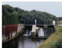
Déversoir de l'étang de l'abbaye de Droiteval (88).
