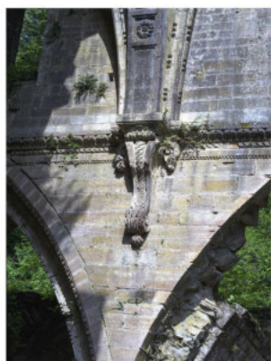
Abbatiale de Trois-Fontaines (51), détail d'une console refaite au XVIII e siècle.
