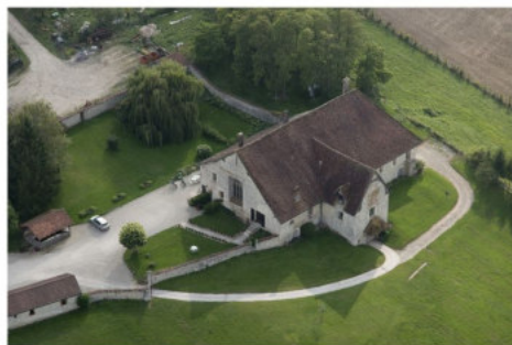
Vue aérienne du cellier.
