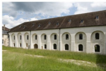
Bâtiment des convers.
