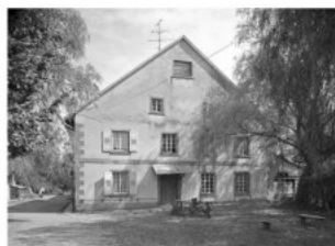
Vue du mur pignon du ancien moulin de l'abbaye (état en 1982).
