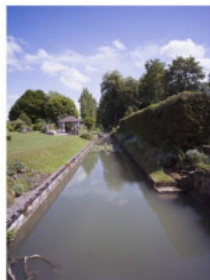
La Bruzennelle canalisée en amont de l'abbaye de Trois-Fontaines (51).
