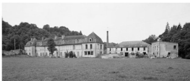
Sur cette vue prise en 1982, on voit à gauche l'ancien logis abbatial et, en second plan, les bâtiments industriels dominés par leur haute cheminée.
