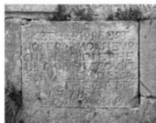
Pierre de fondation datée 1778 d'un pavillon de l'ancien logis abbatial.
