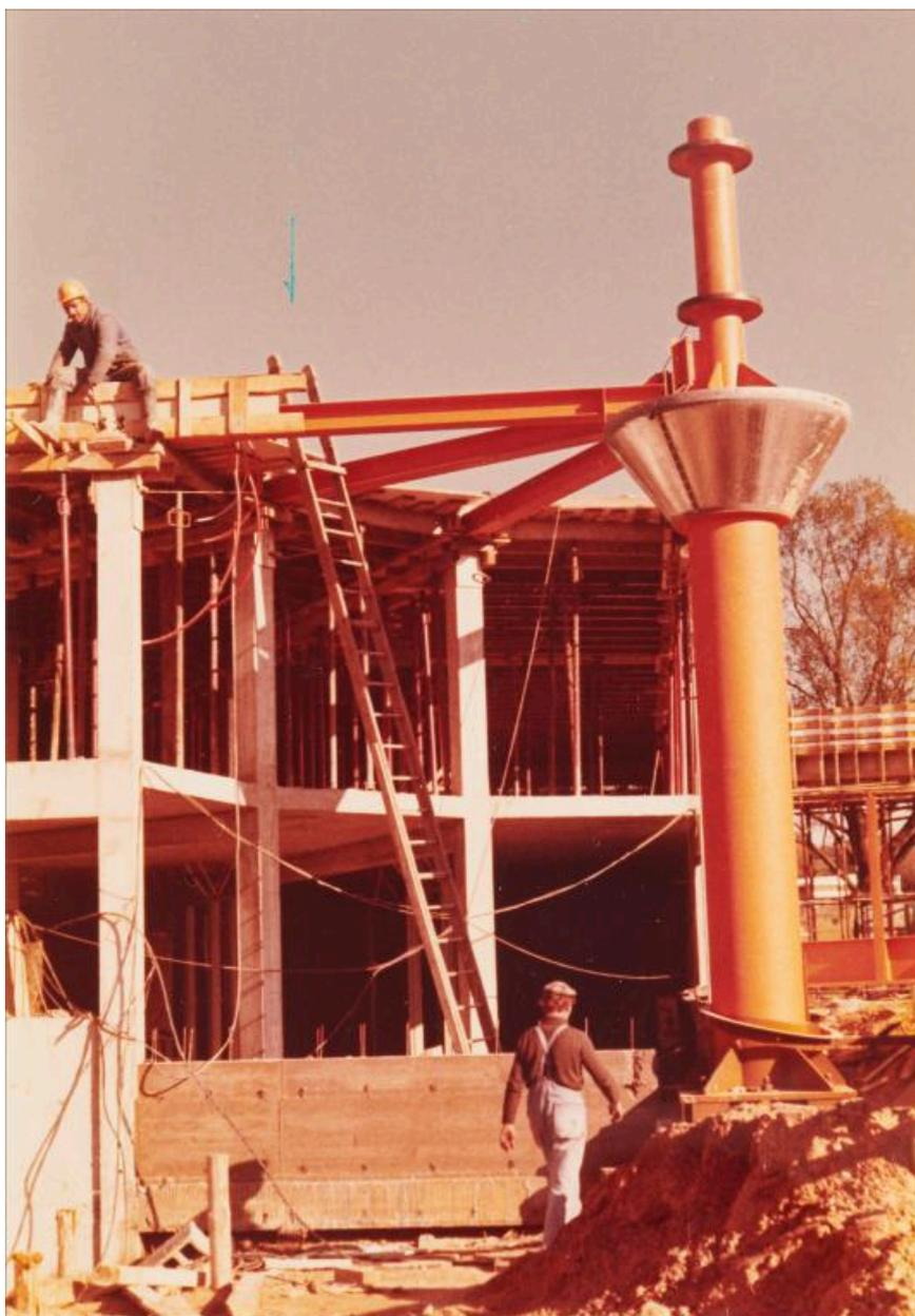
Chantier de construction, vue sur le poteau central sur lequel pivote la toiture, 1973
