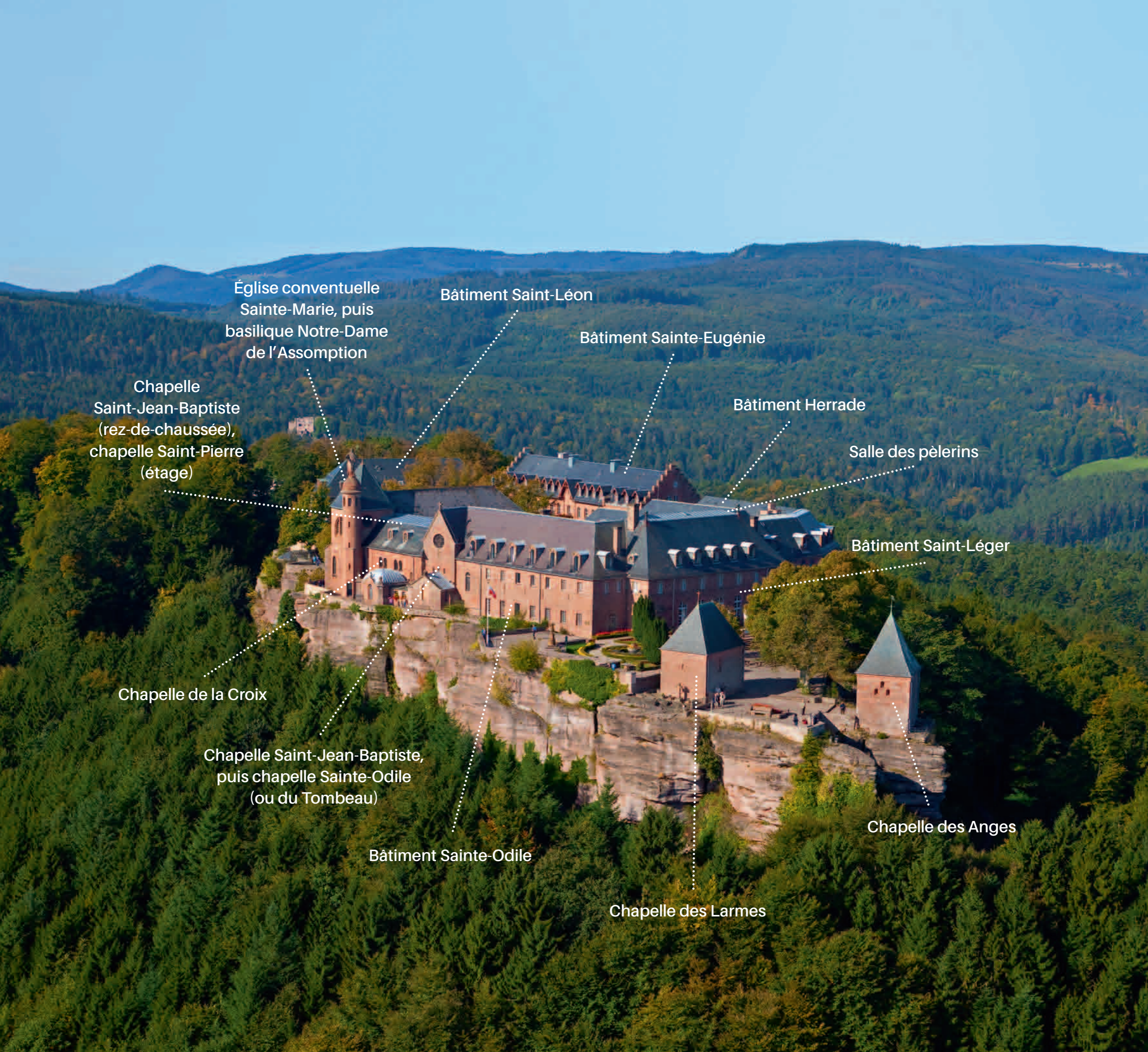
Vue aérienne du sanctuaire du Mont Sainte-Odile avec l'identification des bâtiments.
