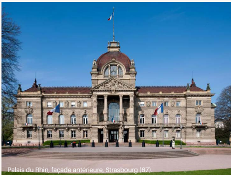
Palais du Rhin, façade antérieure, Strasbourg (67).
