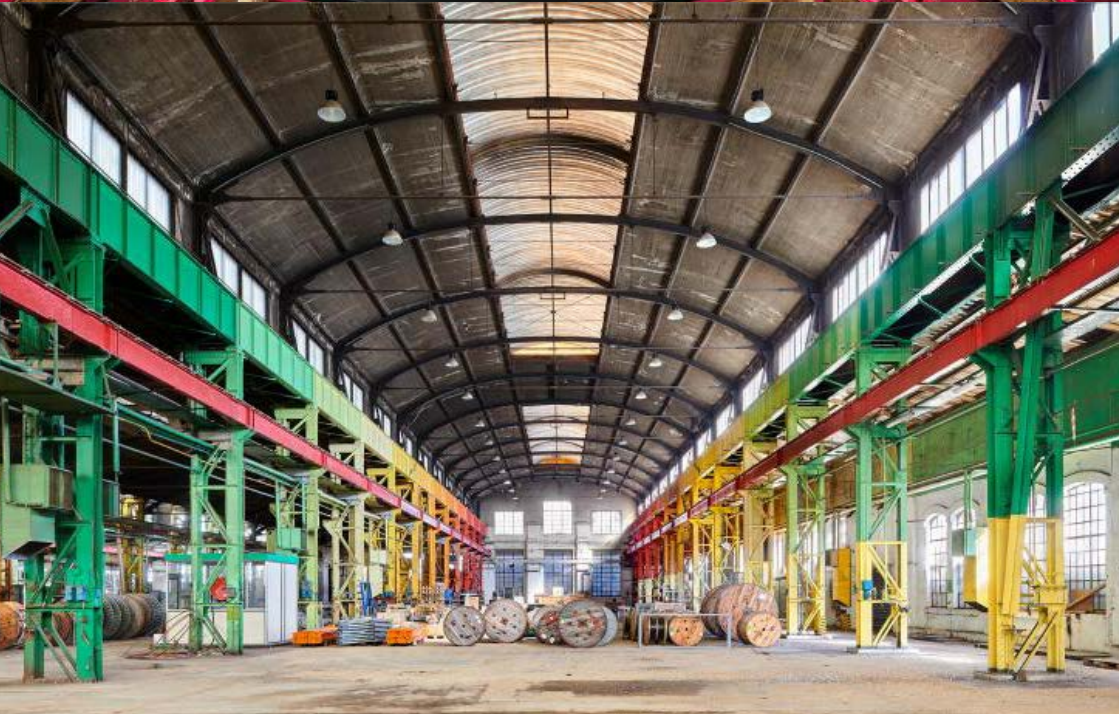
Atelier de réparation des locomotives, Montigny-lès-Metz (57).
