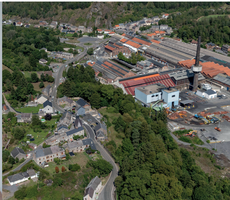
Vue aérienne de l'usine métallurgique Tréfinmétaux, actuellement KME France, à Fromelennes. © Région Grand Est - Inventaire général / Jacques Philippot
